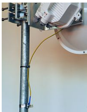
Obr. 4.14: Zemnění jednotky RAY
