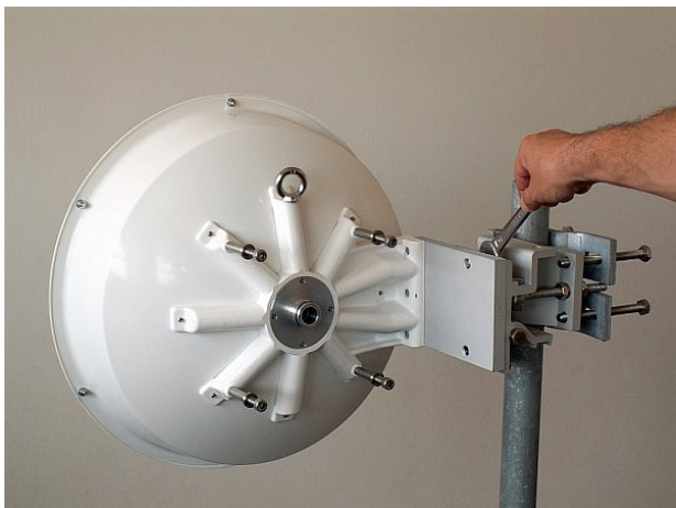
Obr. 5.12: Utažení horního šroubu na desce
