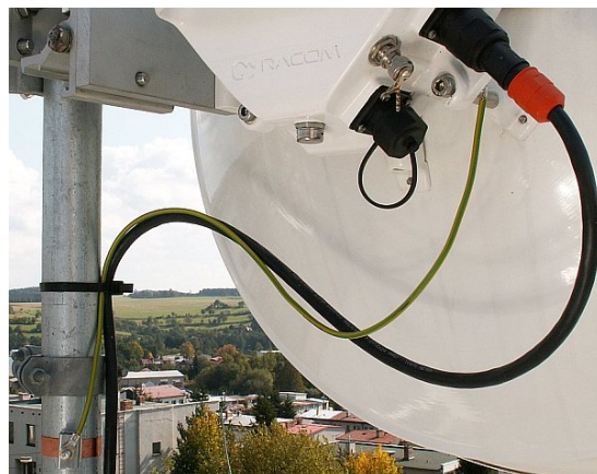
Obr. 5.64: Zemnění jednotky FOD
