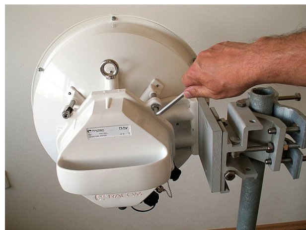
Obr. 5.15: Utažení šroubů na jednotce FOD
