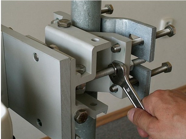
Obr. 5.16: Horizontální nastavení směru antény
