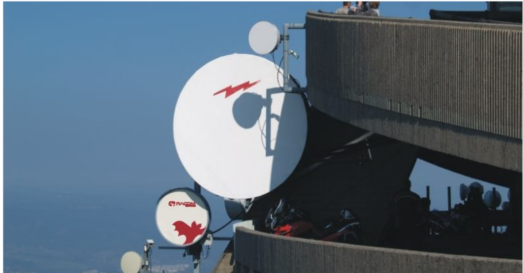
Obr. 5. - ukázka instalace mikrovlnných spojů ve stejném směru.
