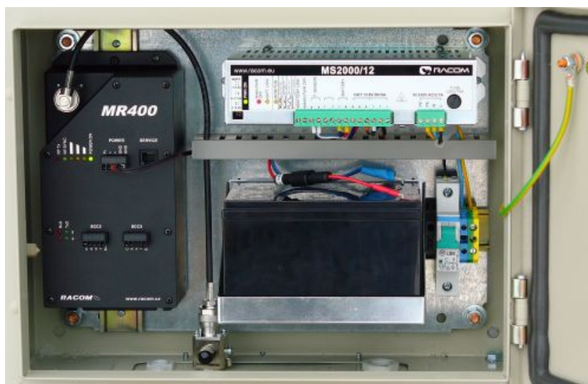
Obr. 6.1: Příklad uspořádání zařízení v rozváděči
