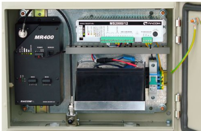
Obr. 6.2: Příklad uspořádání zařízení v rozváděči
